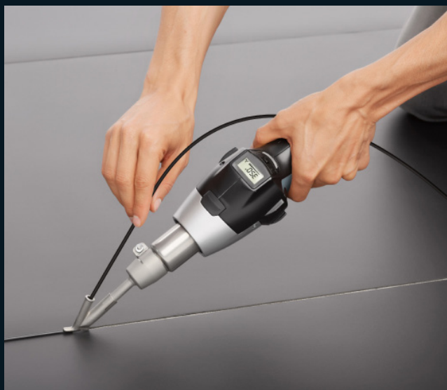
Svařování podlahových linoleových krytin.
