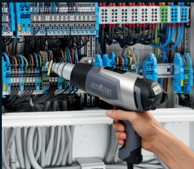
Spojování kabelů v rozvaděči.
