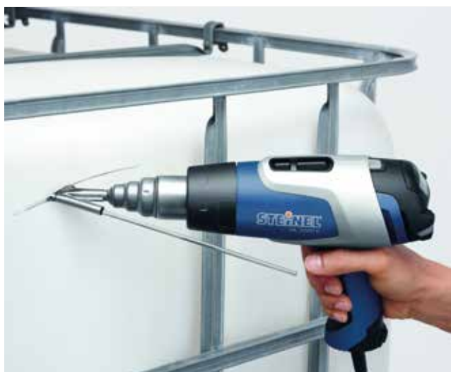
Opravy. Spájení vodní nádrže z PVC.
